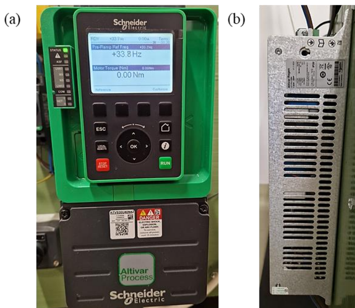
Slika 3.2 (a) Frekventni pretvarač i (b) regenerativna jedinica
