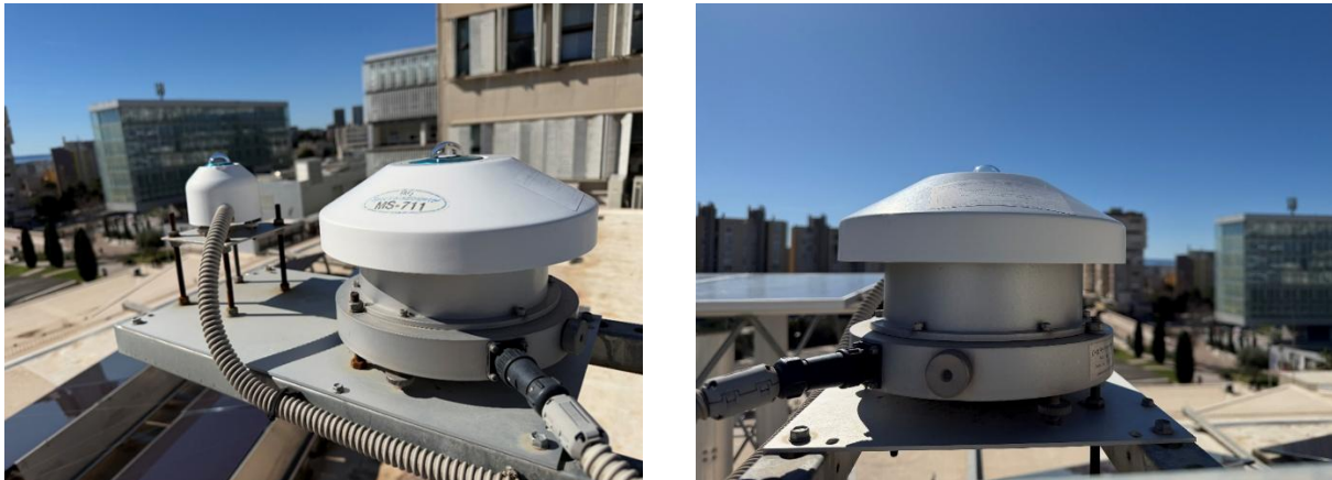
Slika 5.1 MS-711 na krovu FESB-ove zgrade.
